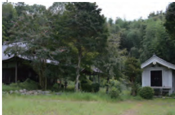
現光寺 本堂・收藏庫
